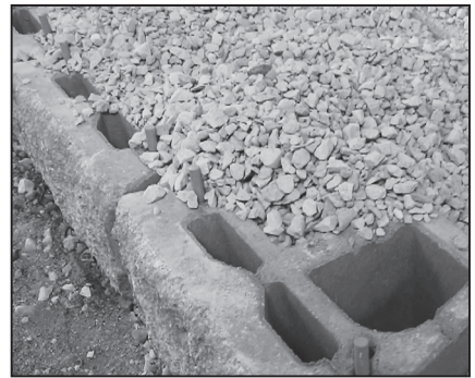
DIAGRAM 6 - CORE FILL
